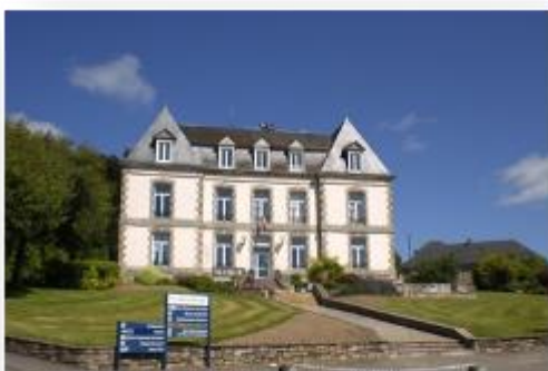
Mairie de Mûr de Bretagne
